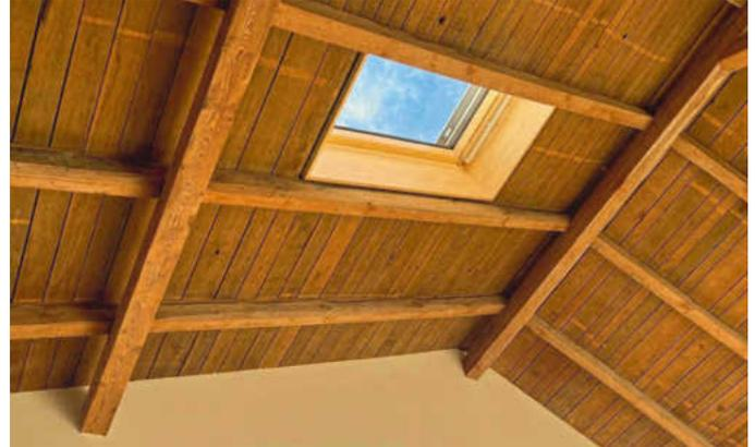
Dachflächenfenster bringen Licht von oben, die Unterseite ist die alte Dachschalung, darüber liegt eine Holzwolledämmebene
