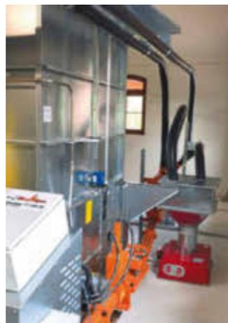
pressen verdichtet. Die Briketts werden automatisch über den Brandschott aus dem Obergeschoss in einen Bunker im Kellergeschoss abgeworfen. Eine Austragung führt die Briketts dann der Heizung zu. Um den optischen Anforderungen des Gebäudes,
