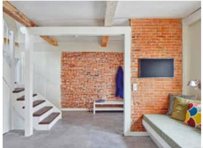
Die originalen Ziegelwände lagen hinter Schichten von Putz, Gips und Holzlatten verborgen und wurden wieder freigelegt
