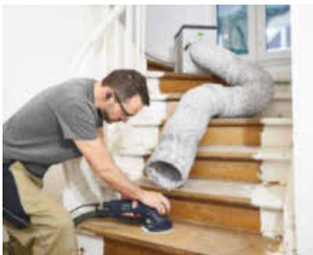
Mit einem Schlauch saugt der Luftreiniger ab, was der Geräteabsaugung entgeht
