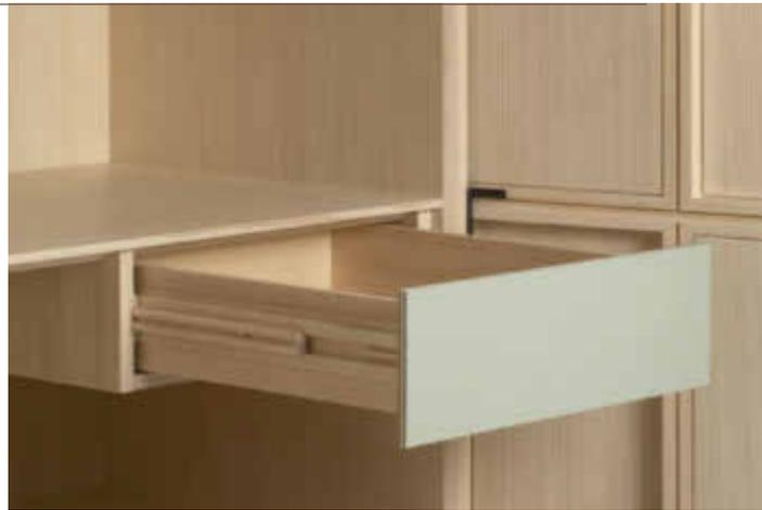
**Auf Kulissen geführter Schubkästen und unkonventioneller Türanschlag mit modifiziertem Zapfenband**
